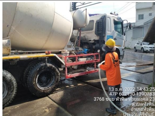
รูปที่ 4 คนงานล้างล้อรถก่อนออกจากโครงการ
