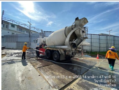
รูปที่ 4 คนงานล้างล้อรถก่อนออกจากโครงการ
