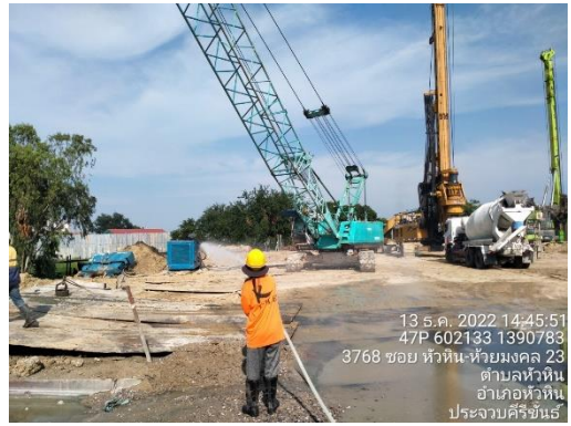
รูปที่ 6 คนงานฉีดพรมน้ำบริเวณพื้นที่ก่อสร้าง
