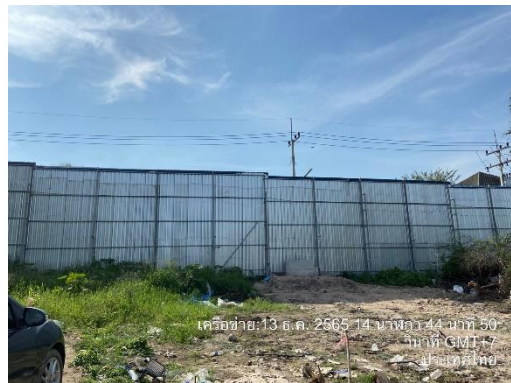
รูปที่ 1 ติดตั้งรั้วทึบชั่วคราว Steel Sheet ความสูง 6 เมตร รอบพื้นที่โครงการ
